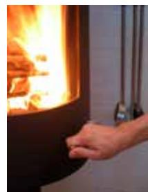
5. Er forudsætningen under pkt. 4 opfyldt, lægges der max. 2 stykker brænde med en samlet vægt på 1,5-2 kg og en længde på 25 cm ind over gløderne i ét lag med en afstand på ca. 1 cm mellem træstykkerne.
